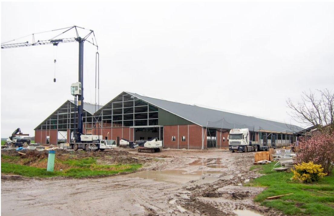
Bouw van een ligboxenstal in Zeewolde in 2015. Er wordt veel staal gebruikt (niet hernieuwbare grondstof). Het bouwproces is deels gemechaniseerd (Bouwbureau Wedekind, Zeewolde).
