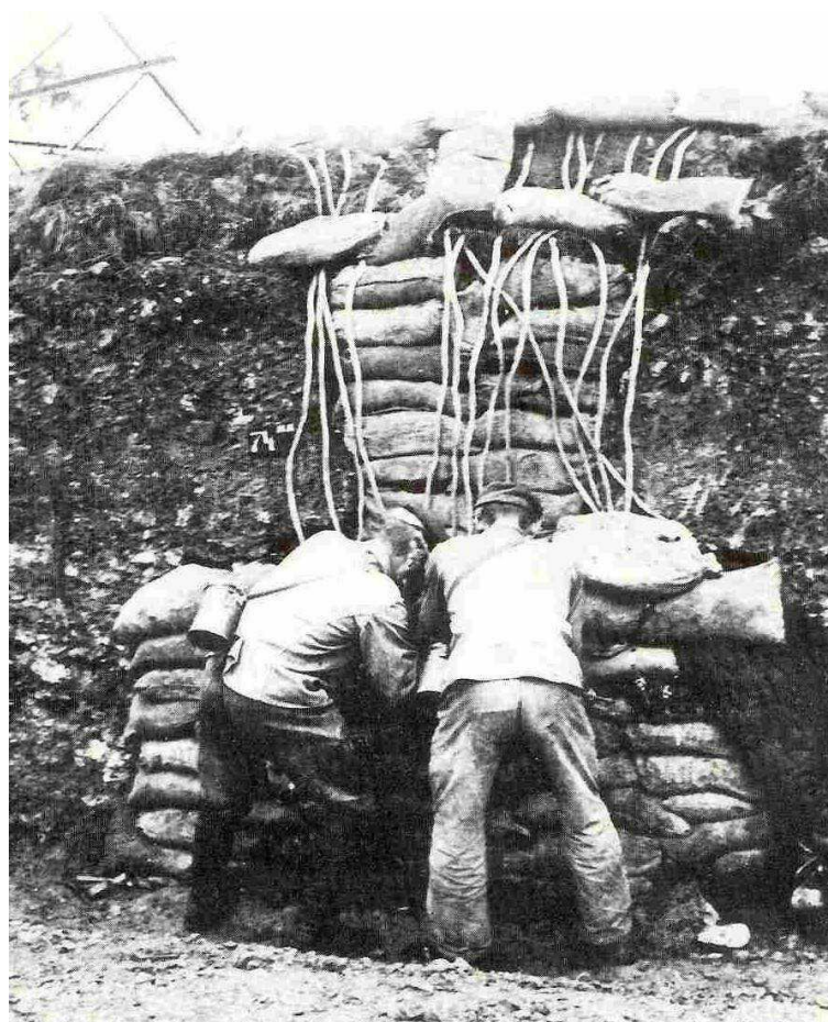
Het ingraven van de chloorcilinders en aanbrengen van de leidingen in de loopgraven.
